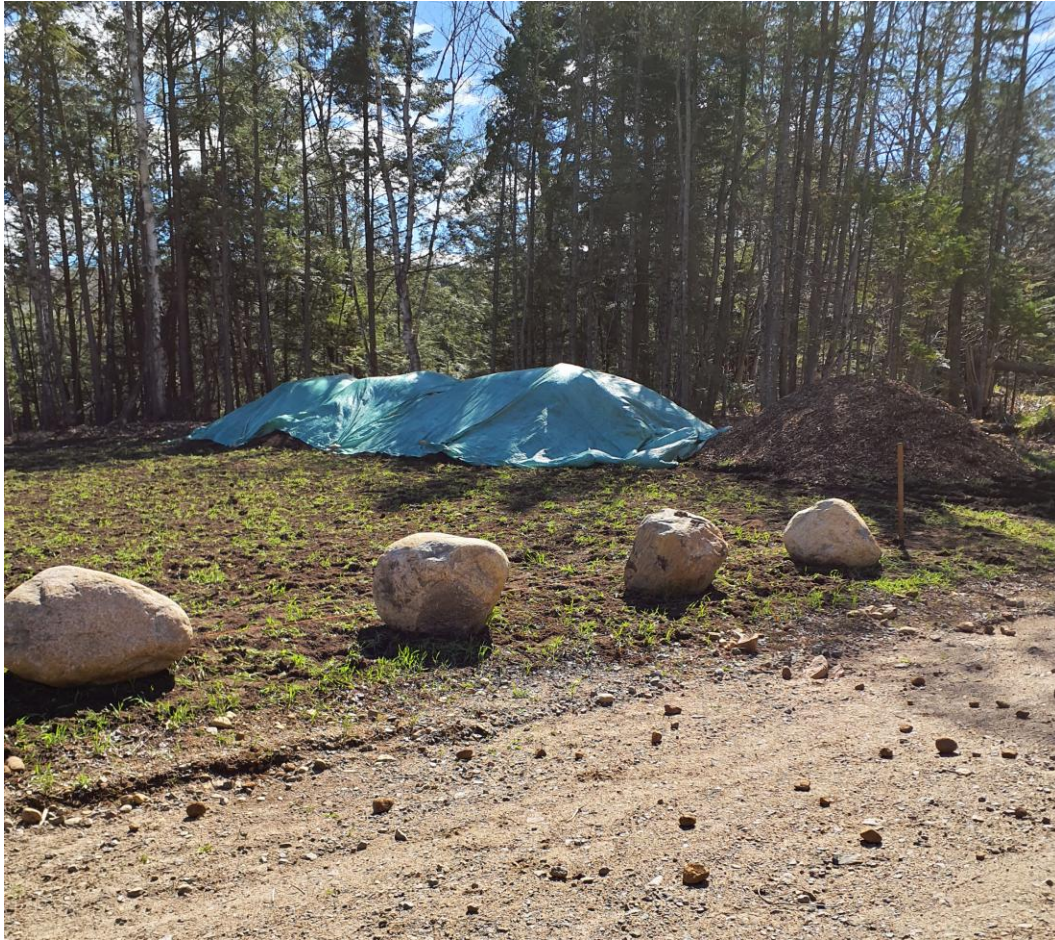
Figure 11 : Exemple d'une bonne pratique, soit l'utilisation d'une bâche pour couvrir un amas de terre près de la rive, lac Lambert 2024
